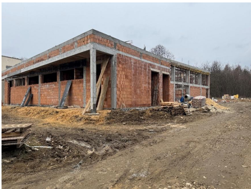
Fot. 6. „Rozbudowa budynku Zespołu Szkolno-Przedszkolnego o salę gimnastyczną z zapleczem szatniowym i higieniczno-sanitarnym w miejscowości Rększowice”.
