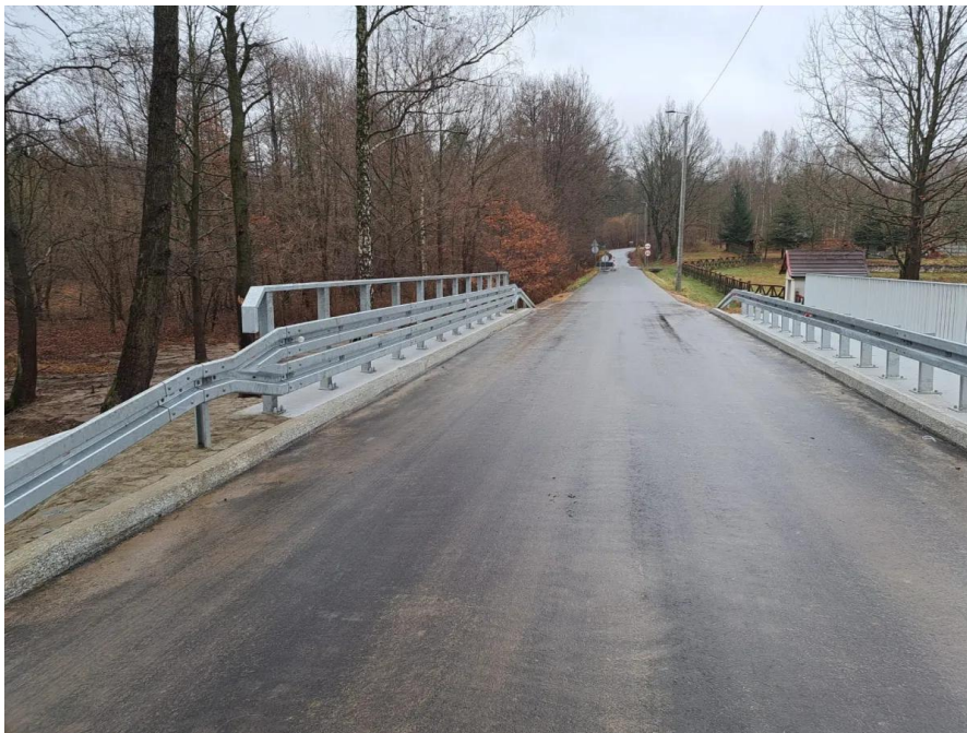
Fot. 5. „Przebudowa mostu drogowego w ciągu drogi gminnej ul. Przyrodnicza nad rzeką Rększowiczanka w miejscowości Rększowice”.
