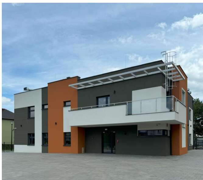
Fot. 7. „Rozbudowa i nadbudowa istniejącego budynku usługowego wraz z niezbędną przebudową na potrzeby Domu Seniora w Konopiskach”.
