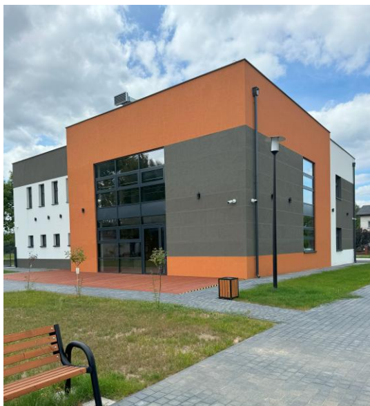
Fot. 8. „Rozbudowa i nadbudowa istniejącego budynku usługowego wraz z niezbędną przebudową na potrzeby Domu Seniora w Konopiskach”.
